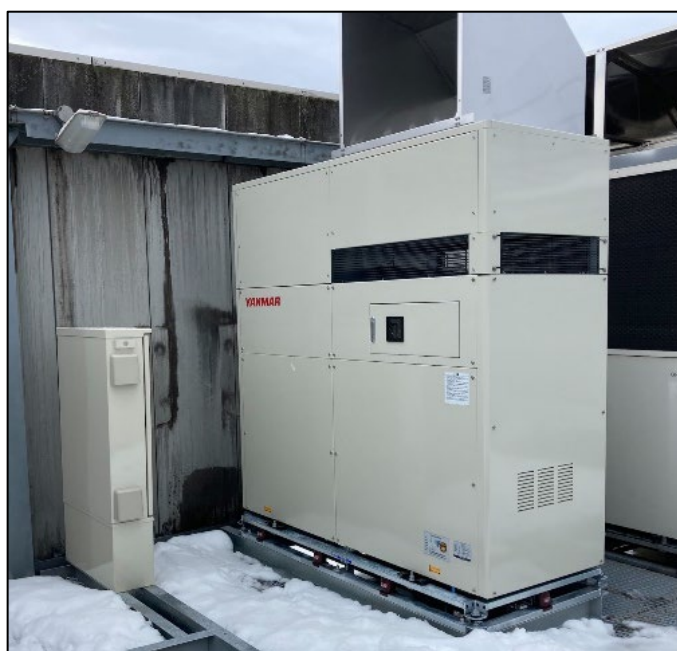
停電対応型ガスコージェネレーションシステム（都市ガス）
